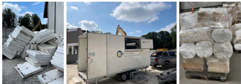
Afbeelding 2: EPS wordt op de sloop door FZ Recycling gecompacteert
