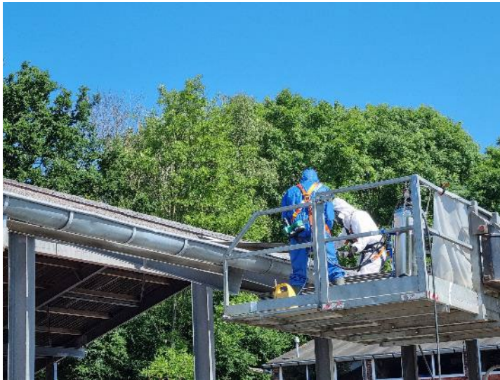
Foto 23: Plaatsen (schuiven) asbestcement golfplaat in de bak van de verreiker
