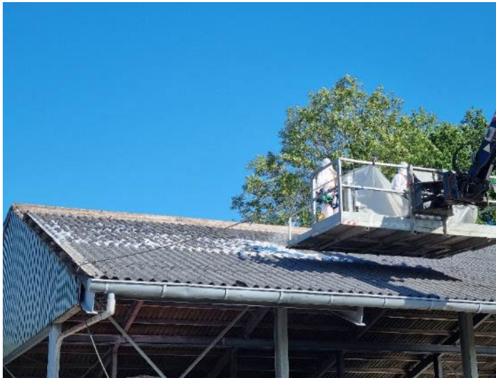
Foto 12: Vooraanzicht asbestdak, deel van de golfplaten zijn verwijderd (met name nokstukken aan zijkant en voorkant).
