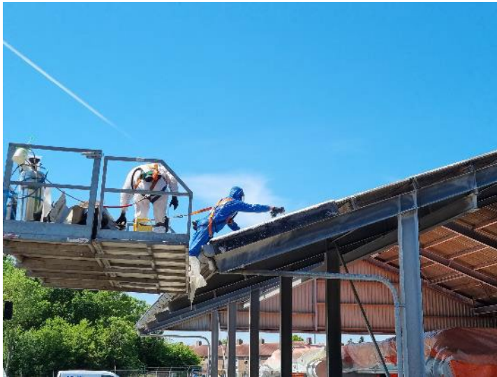
Foto 29: Losschroeven dakbouten de uit de asbestcement golfplaat (nokstuk zijkant)
