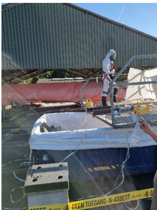
Foto 11: Plaatsen verwijderde nokstukken e.d. in de afvalcontainer
