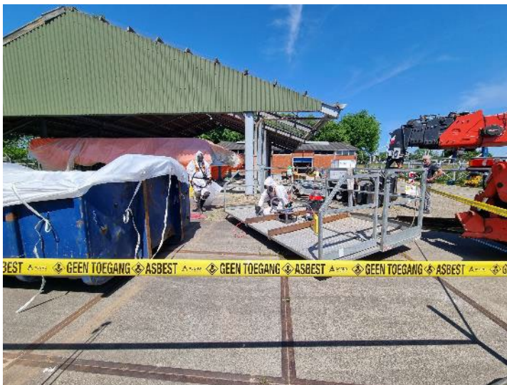
Foto 40: Schoonmaakwerkzaamheden, oprapen brokstukjes (handpicking, links) en stofzuigen bak verreiker (rechts)
