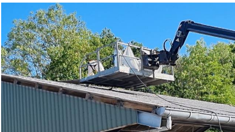
Foto 15: Verplaatsen (schuiven) asbestcement golfplaat naar bak verreiker
