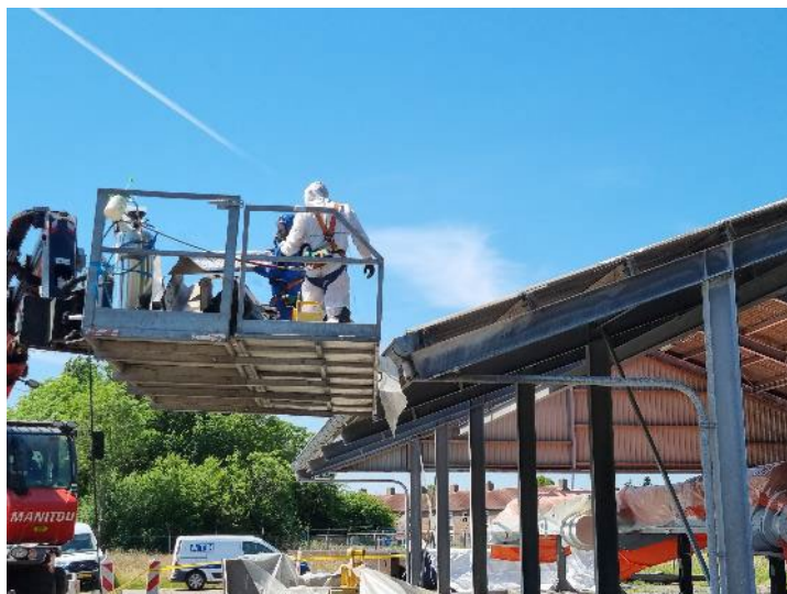
Foto 31: Plaatsen nokstuk in de bak van de verreiker
