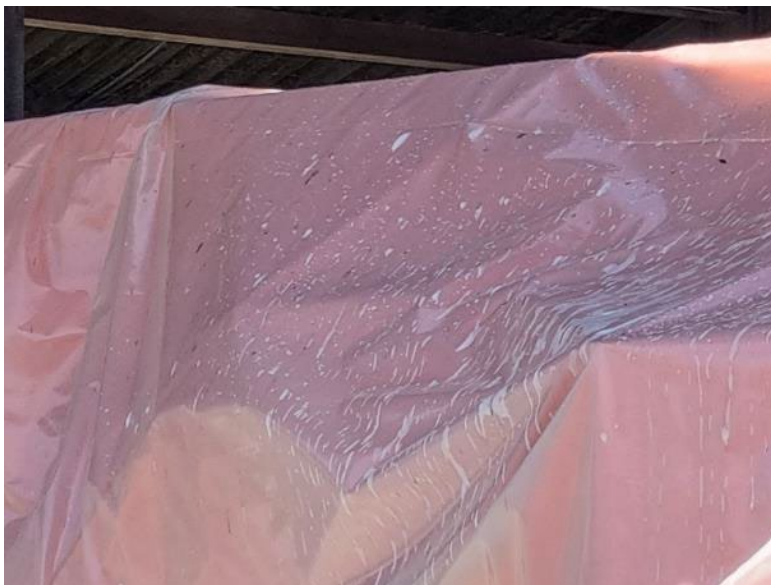
Foto 36: Zeil op objecten in de deurenloods onder asbestdak, schuim valt op het zeil tijdens inschuimen dakspanten (zie vorige foto's)
