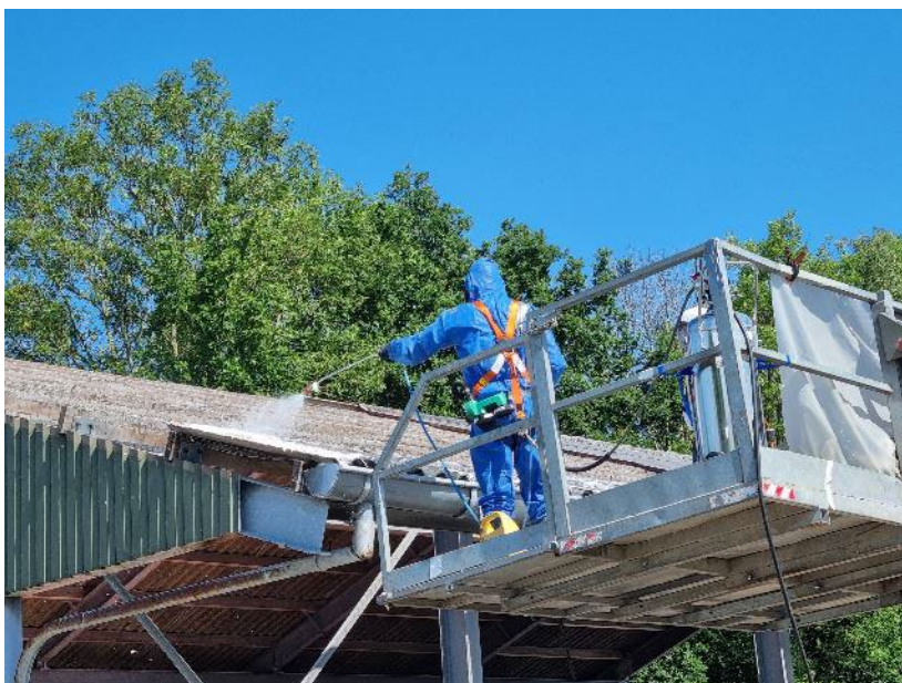
Foto 22: Inschuimen asbestdak vanuit verreiker
