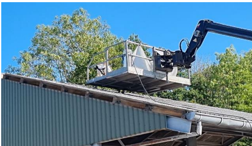
Foto 14: Oppakken asbestcement golfplaat vanuit verreiker
