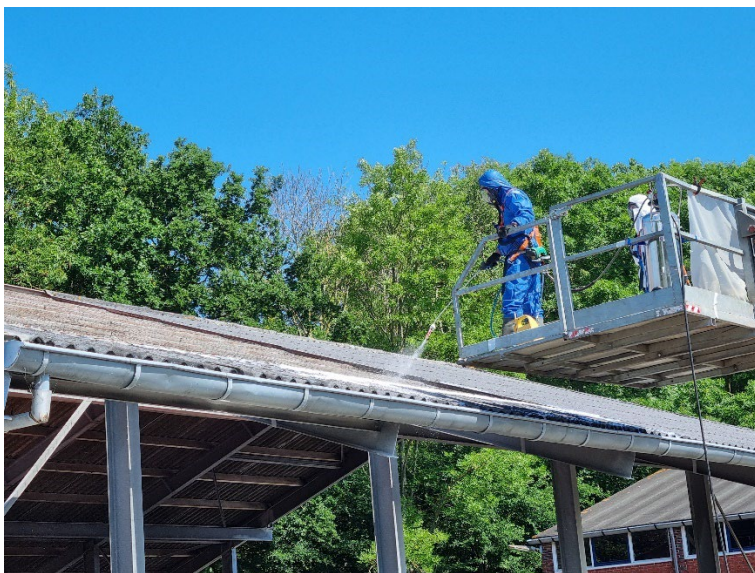
Foto 20: Inschuimen volgend deel van de golfplaten
