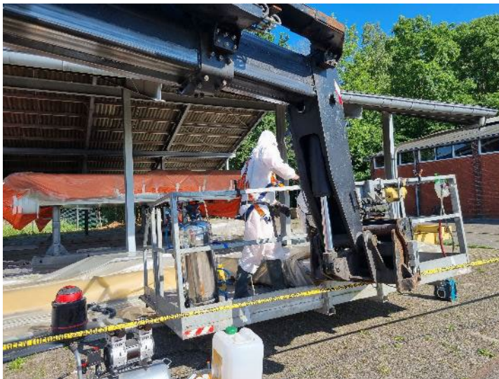
Foto 18: Inpakken verwijderde asbestcement golfplaten
