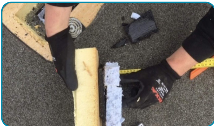
Afbeelding 1. Voorbeelden dak uitsnede PIR/PUR platen
